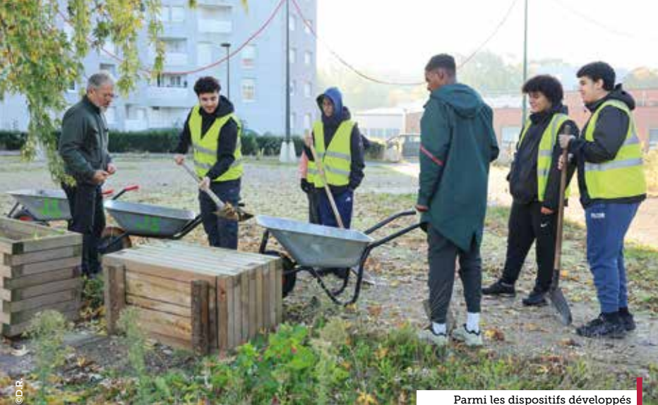
Parmi les dispositifs développés par l'OMJT, les chantiers citoyens.
