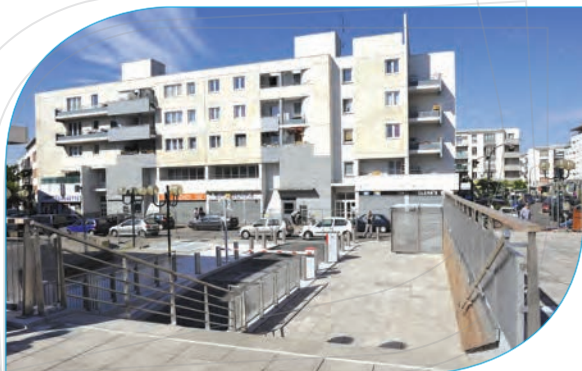
Entrée du parking de l'Hôtel de ville, allée Nelson Mandela
