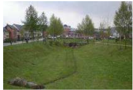
Bassin d'infiltration enherbé
