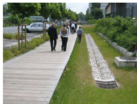
Noue de stockage à Clichy-sous-Bois
